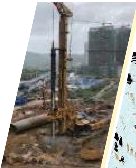
贵阳立交桥 抗滑桩项目
