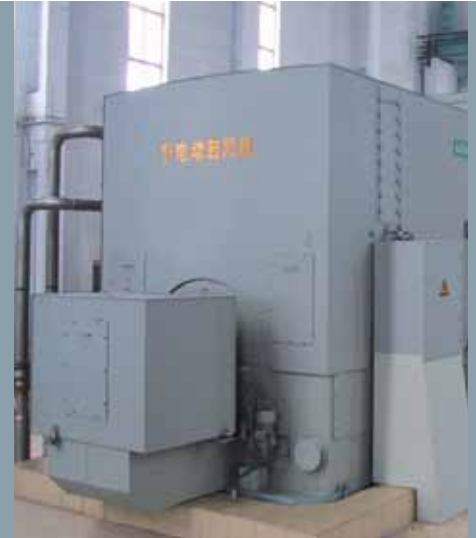
中国鞍山钢铁厂中的一台用于高炉鼓风机的 42 MW 电机
