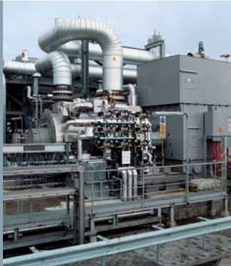
转速高达 6300 rpm 的 23 MW 电机，用于在荷兰格罗宁根市南部输送气体
