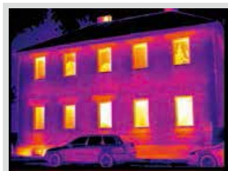
建筑热工缺陷检测
