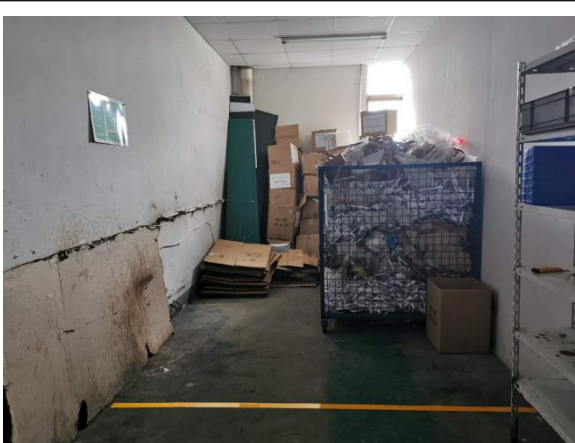
图 3-4 一般固体废物暂存间全景
