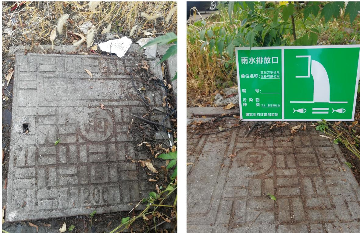
图 3-2 雨水排口及标识照片
