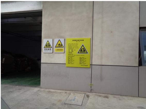
危险废物仓库标识牌
