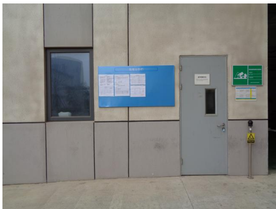
一般固废仓库外部标识牌
