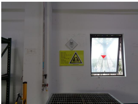
危险废物仓库内部分类
