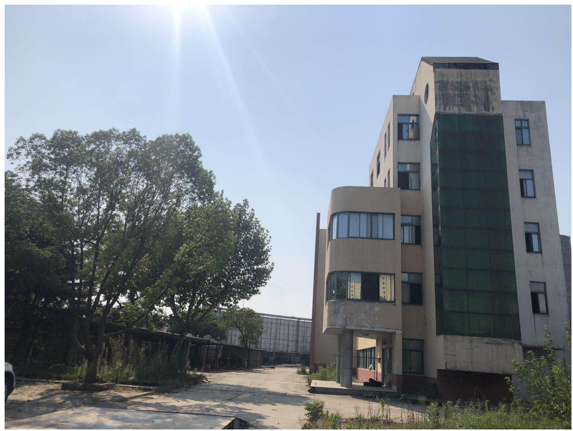
厂区西南侧，宿舍楼
