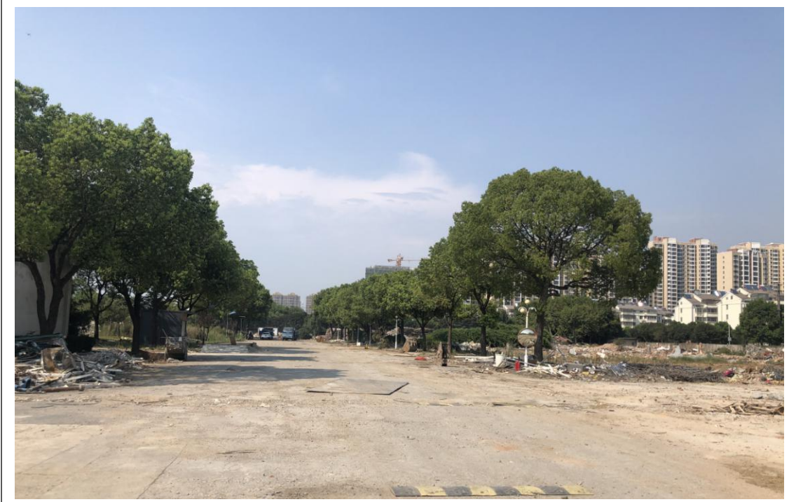
厂区内南北向中间主通道
