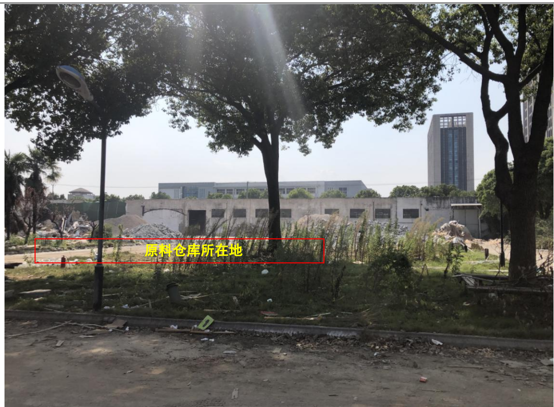
厂区西侧，原料仓库已拆除，现存建筑物成品仓库
