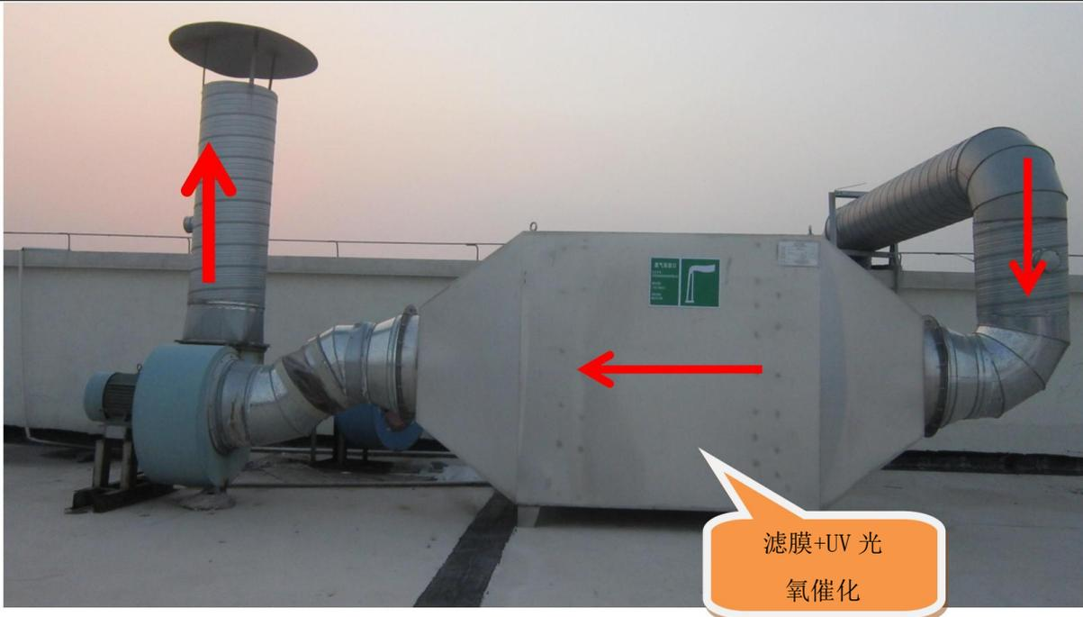
图 3-2 废气处理及排放装置组图
