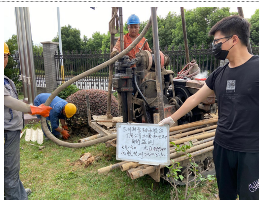
附图 6 监测井钻孔
