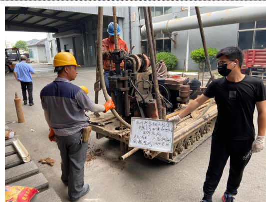
附图 1 土壤钻孔
