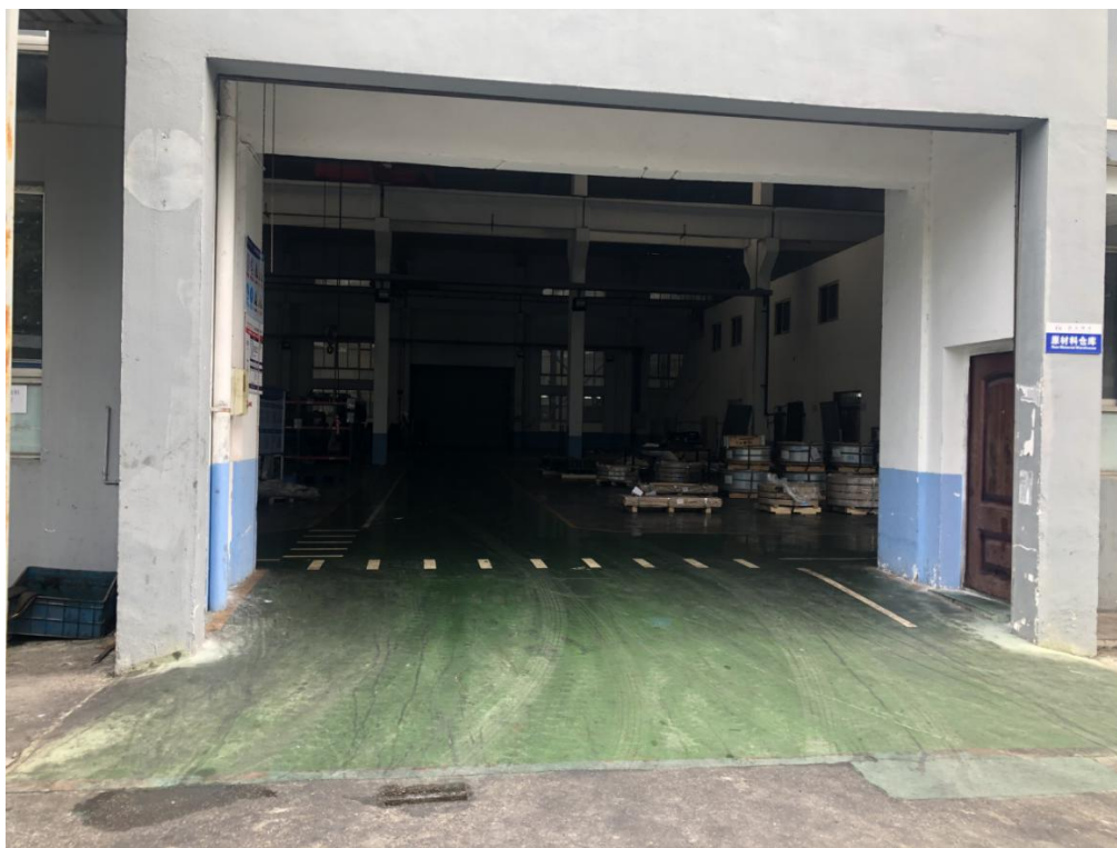
图 4-1 仓库外部情况
