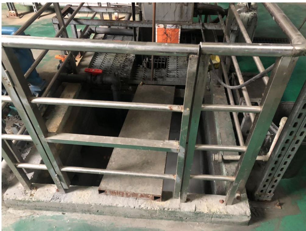
图 4-12 污水处理站地下设施
