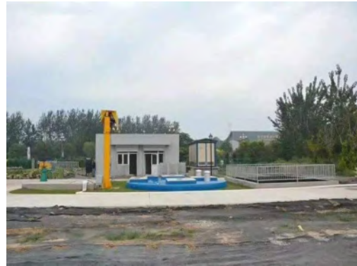
智能一体化预制泵站
