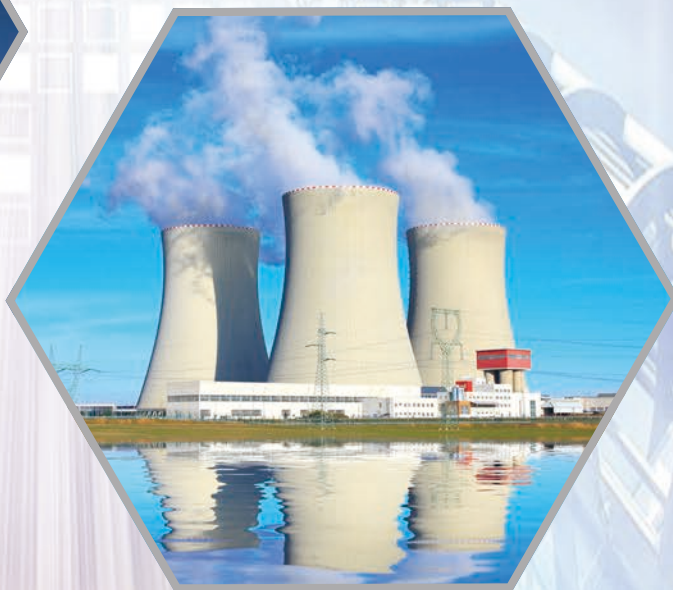
发电/燃煤锅炉/焚烧炉
