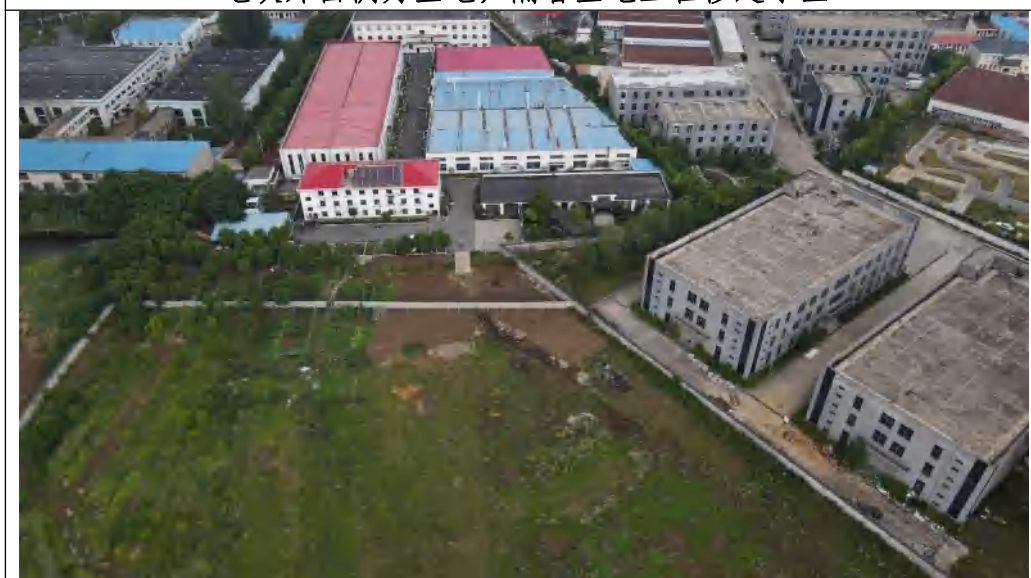
地块外北侧为安徽银龙泵阀股份有限公司
