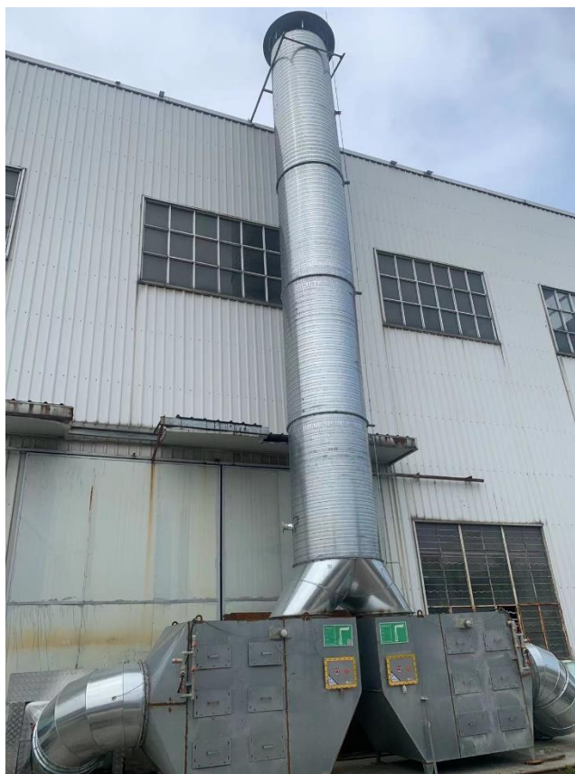
图 8-1 改造完成后实拍图
