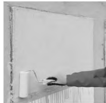
图6 挤压、滚涂第二道毡胶复合层施工图
